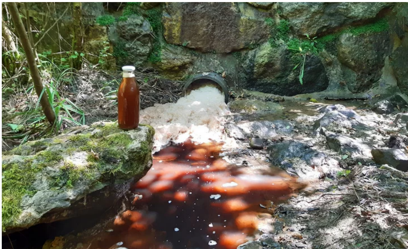
Aspecto de las aguas que salían de la incineradora a mediados del pasado julio y que se vertían en la regata de Aitzerreka. (ERRAUSTEGIAREN AURKAKO MUGIMENDUA)
